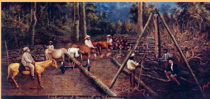
Trabajos en el ferrocarril en Chiguacac, óleo de José Grijalva
