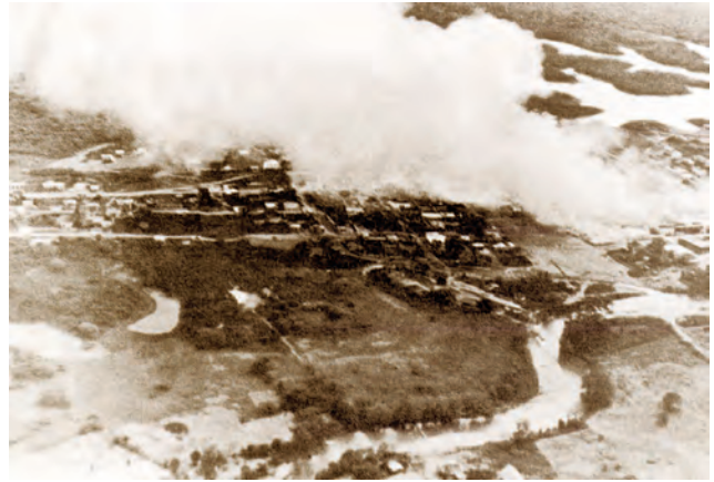
Destrozos causados en Santa Rosa por el bombardeo peruano el 24 de julio de 1941 Foto: BCE
