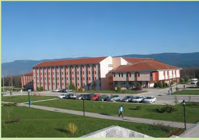
Bolu, Abant - İzzet Baysal Üniversitesi Gökçöy Yerleşkesi
