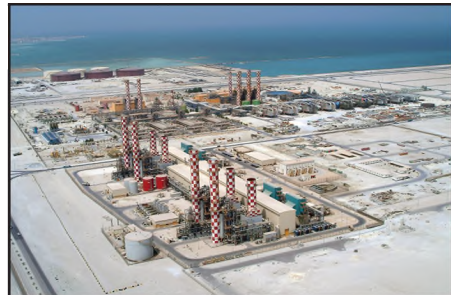
■ محطة الحد للكهرباء والماء
