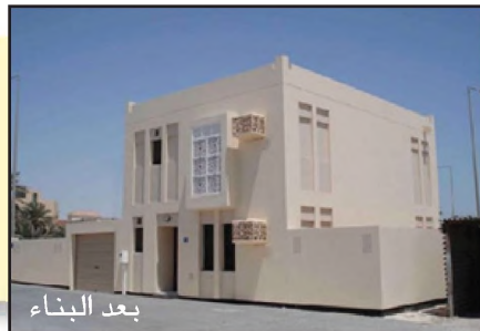
مذبل بُني ضمن مشروع ترميم وإعادة بناء البيوت الآيلة للسقوط
