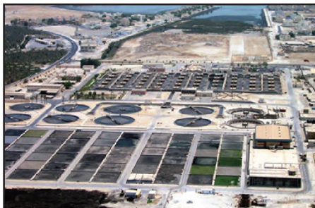
■ محطة توبلي لمعالجة مياه الصرف الصحي
