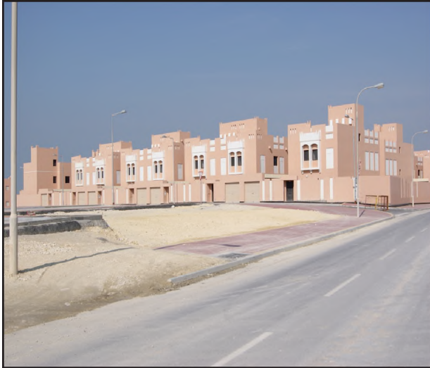
٤- أبنية سكنية حديثة مبنية بالطابوق والأسمنت.
