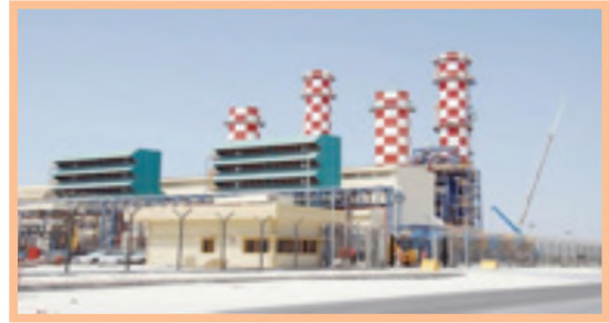
مستند رقم ٣: محطة كهرباء
