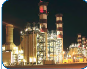
عدم صيانة محطات توليد الكهرباء
