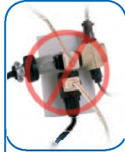
تحميل قوالب الكهرباء فوق طاقتها
