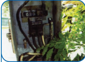
احتراق المحولات الكهربائية
