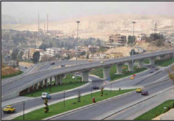
الصورة (٦) شبكة طرق حديثة
