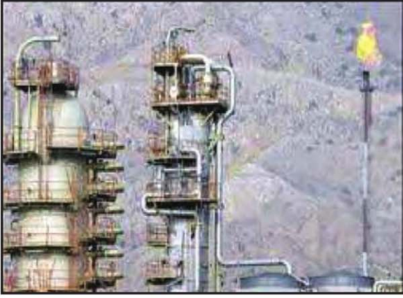
الصورة (٢٢) مصفاة نفط سورية
