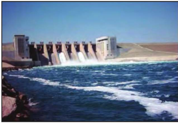
الصورة (١٤) سدُّ الفرات
