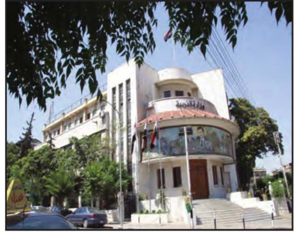
الصورة (١٠) مبنى وزارة التربية
