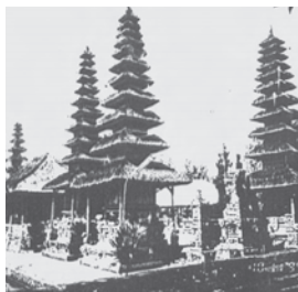
Gambar 11.24 Meru pada bangunan Pure Taman Ayun Bali. Sumber: Dokumen Pribadi
