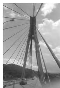
Gambar 2.4: Jembatan peng- hubung antarpulau di Batam Sumber: Dokumen Pribadi
