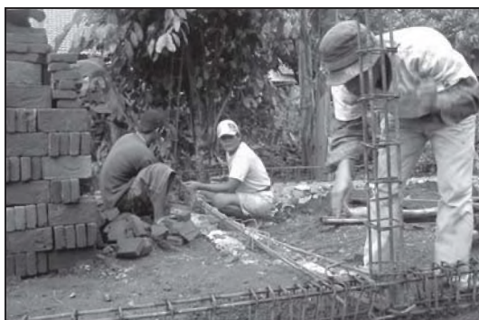
Gambar 4.7 Buruh bekerja di proyek bangunan.
