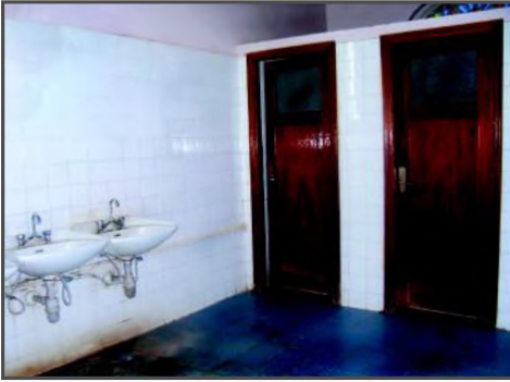
شكل (٧) دورة مياه
