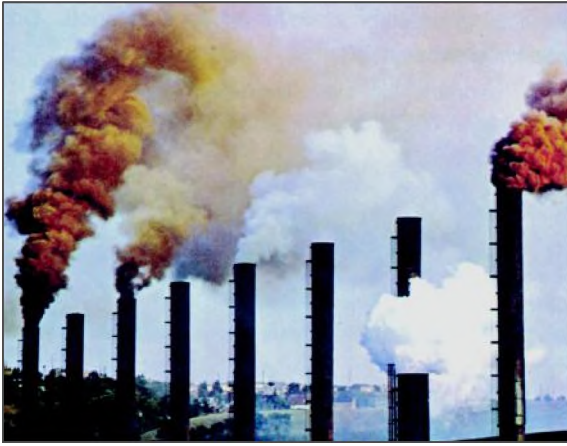
شكل (١) مداخن المصانع
