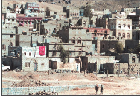
شكل (١) حي سكني مبني بطريقة عشوائية
