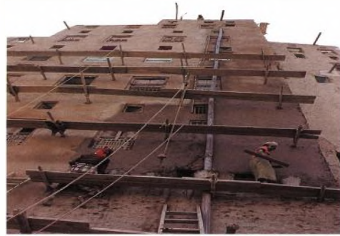
أشخاص يعملون في ترميم المباني الطينية
