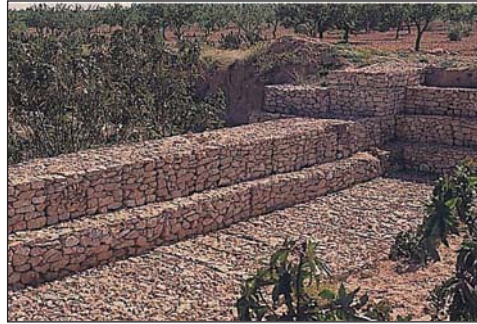
صورة وحدة تغذية مائدة سطحية مقامة في مجرى واد سفيسيفة بجهة القيروان.
