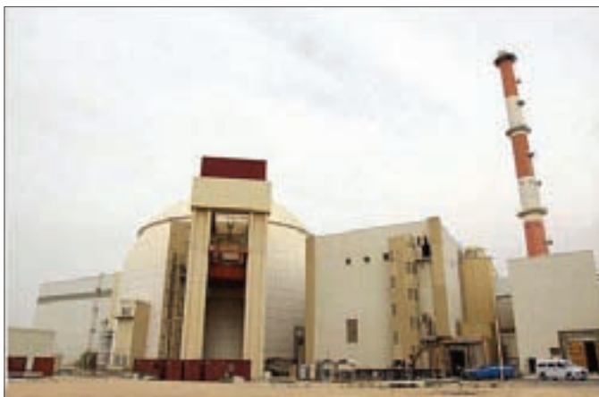
▲ نیروگاه اتمی بوشهر
