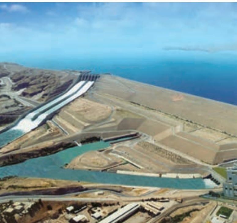
شکل ۱۲-۹- سد و نیروگاه آبی کرخه شیوه‌ای نو برای بهره‌برداری از آب‌های سطحی
