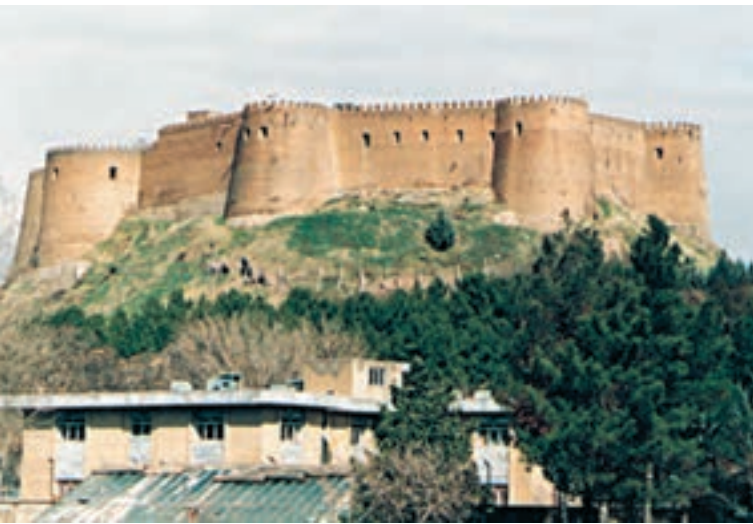
شکل ۲۵-۷. قلعه فلک الافلاک - خرم آباد
