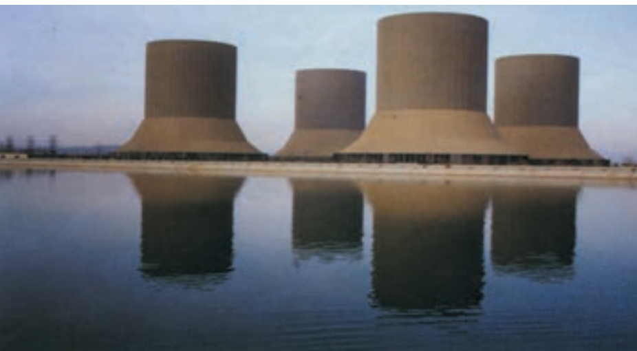
شکل ۱۷-۹- استفاده مجدد از آب مصرفی در نیروگاه‌ها (نیروگاه شهید رجایی - قزوین)
