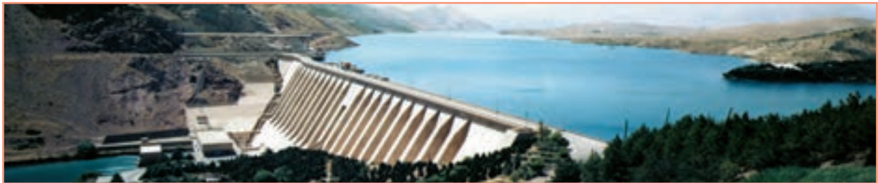
شکل ۲۸-۶- احداث سد روشی برای کاهش خطر خشک‌سالی
