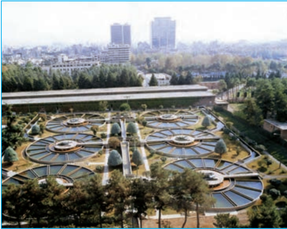
شکل ۱۴-۹- تصفیه خانه شماره ۲ آب تهران - جلالیه
