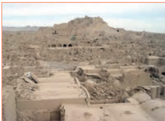
ب) ارگ بم بعد از وقوع زلزله
