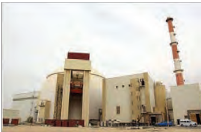
نیروگاه اتمی بوشهر
